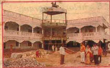
భవననిర్మాణ పనులను పరిశీలిస్తున్న డీఆర్ డీఏ పీడి చిరంజీవులు
